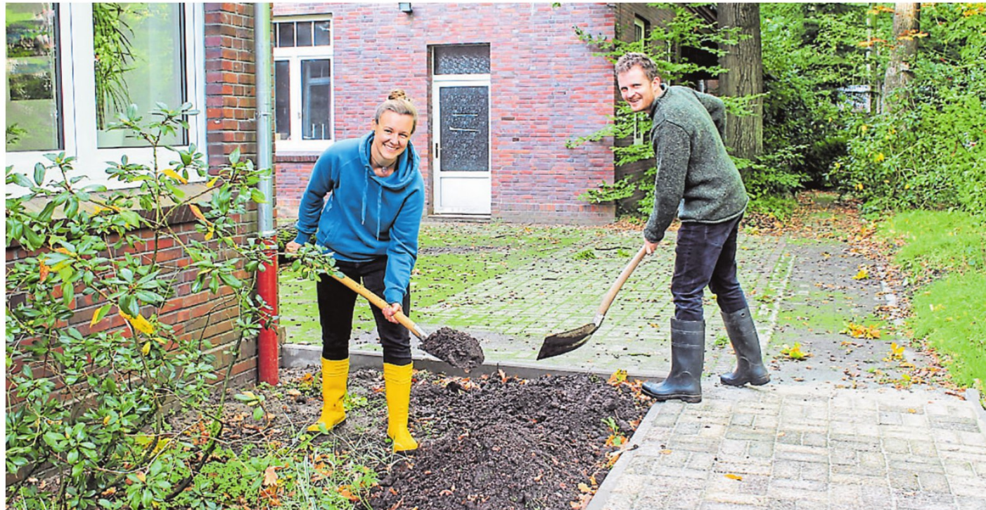
Dr. Ilka Strubelt, Geschäftsführerin der Naturschutzstiftung Friesland-Wittmund-Wilhelmshaven, und Thomas Linß, Mitarbeiter im Projekt Schaufenster Biodiversität der Naturschutzstiftung, bei den ersten Arbeiten für die Anlage des ökologischen Gartens vor dem Stiftungsgebäude im Wittmunder Wald.
