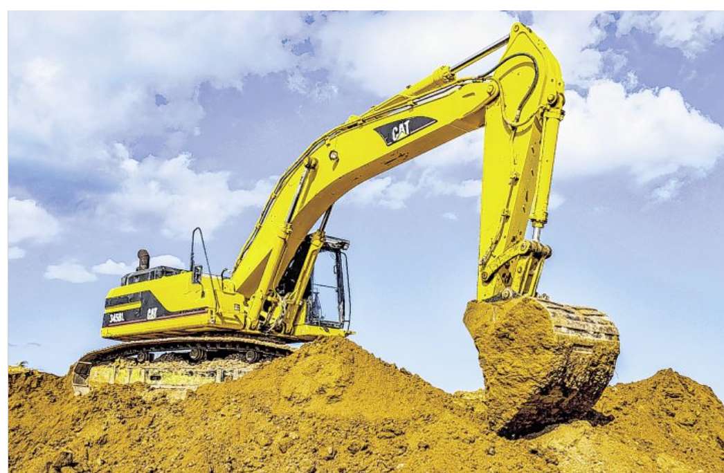
Gute Nachrichten für Bauwillige in Norden: In den kommenden Jahren soll sich viel tun.
